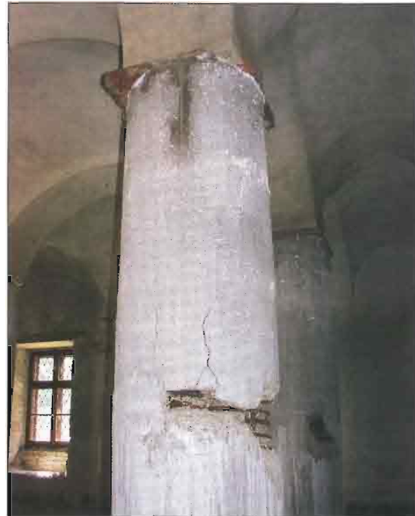
4 Ekspanzija hrđe na željeznoj zatezi uzrokovala je stvaranje radijalnih pukotina u kamenjima (trijem palače Sponza u Dubrovniku)
