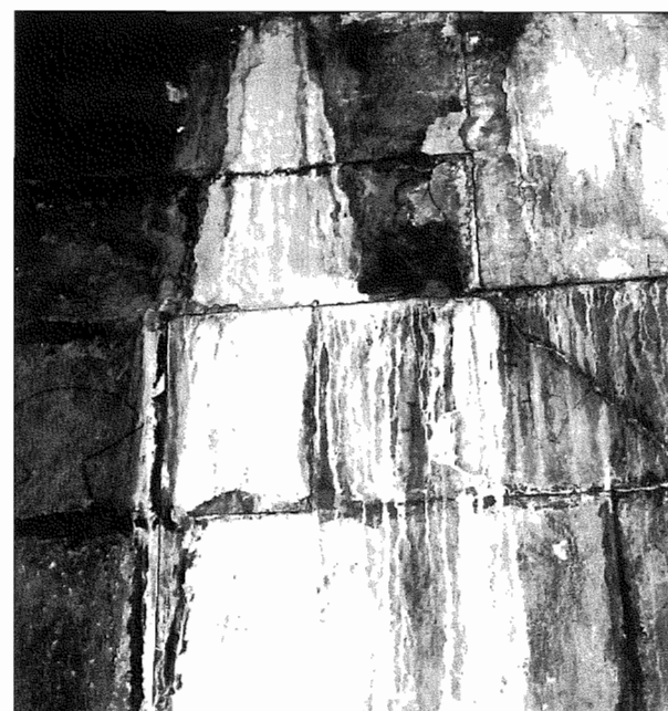
18 Cjedine nastale dugotrajnim prodiranjem kiše kroz reške na kamenom krovu šibenske katedrale
