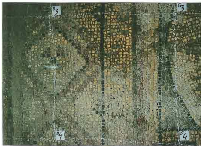
38 Česta kondenzacija vlage iz zraka na podnom je mozaiku u pulskoj katedrali uzrokovala nastajanje kalcitne skrame. Frequent condensation of humidity from the air on a floor mosaic in Pula Cathedral has led to the creation of a calcite film.
