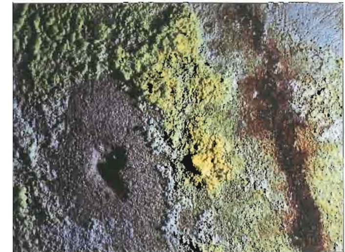
24 Nakupine soli i mikroorganizama na Rangerovoj freski u bivšoj franjevačkoj ljekarni u Varaždinu
