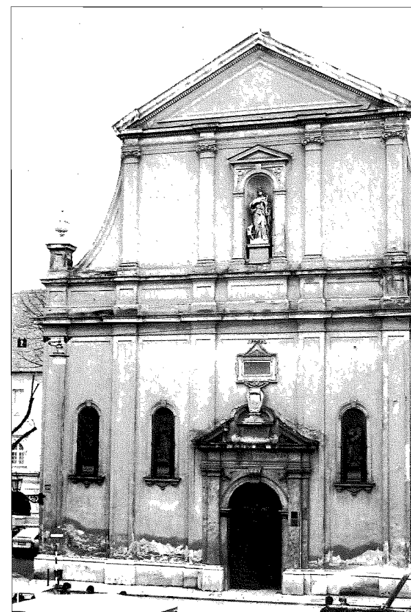
3 Tragovi štetnoga djelovanja vlage u temeljnome dijelu pročelja crkve sv. Katarine u Zagrebu
