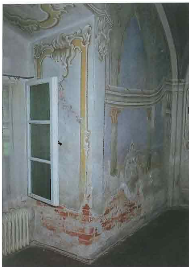
26 Štete od kapilarne vlage i soli na oslikanome zidu Vjenčao- ne u Ludbregu
