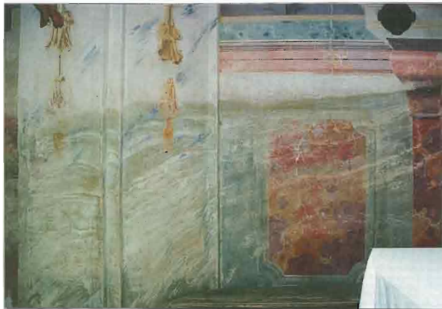
11 Tragovi postupnoga kapilarnog uzlaza vlage u oslikanoj zidu kapele sv. Jurja u Purgu Lepoglavskoj
